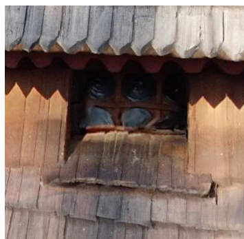
Obr. 27 Okno pod 3. věží, detail chyby modelu. 172
