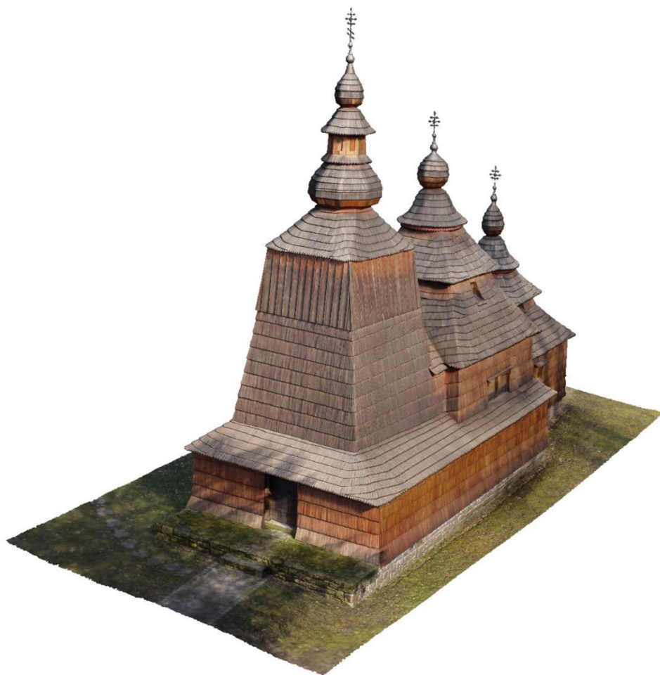
Obr. 29 Výsledný model v programu Agisoft Metashape Professional spočítán pomocí cloud computingu. 178
