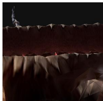
Obr. 28 Krov okna (ze spodu), detail chyby modelu. 173
