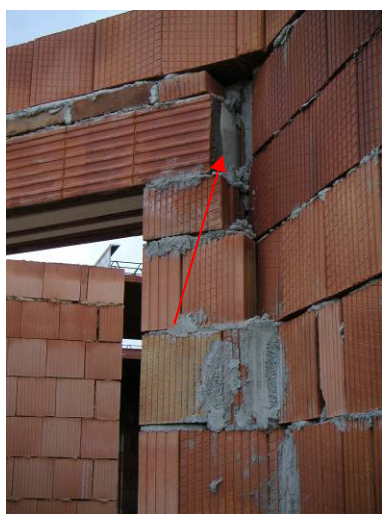
Obr 33, 34: Vadný způsob napojení stěny z Porotherm cihelných bloků a překlady, místo není vyplněné zdivem v plné tloušťce, při doplnění jen maltou vzniká tepelný most (Brada 2015)
