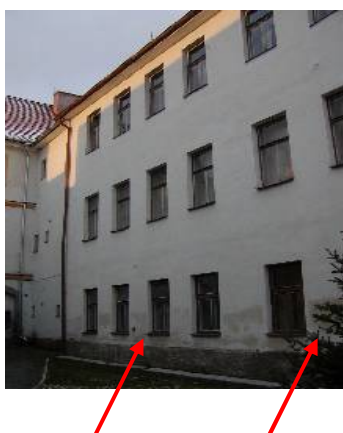
Obr. 15, 16: Příklady projevů nasákavosti zemní vlhkosti včetně opadávání omítky u nadzemního zdiva při špatné hydroizolaci. (Brada 2015)
