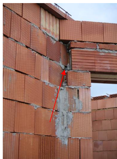
Obr 33, 34: Vadný způsob napojení stěny z Porotherm cihelných bloků a překlady, místo není vyplněné zdivem v plné tloušťce, při doplnění jen maltou vzniká tepelný most (Brada 2015)
