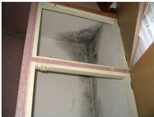
Obr. 31 Příklad plísní v důsledku nevětraného prostoru ve spojení se skladováním vlhkých organických materiálů (Brada 2016)
