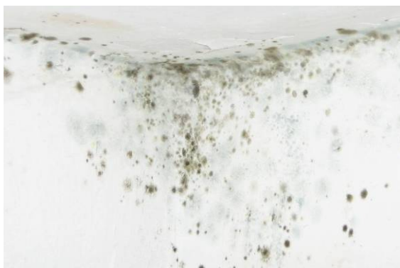
Obr. 21: Příklad kondenzace vlhkosti ve studeném rohu místnosti (Brada 2016)
