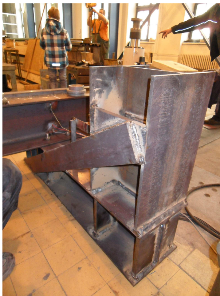
Obrázek 10.12 – Fotografie střední podpěrné konstrukce.
