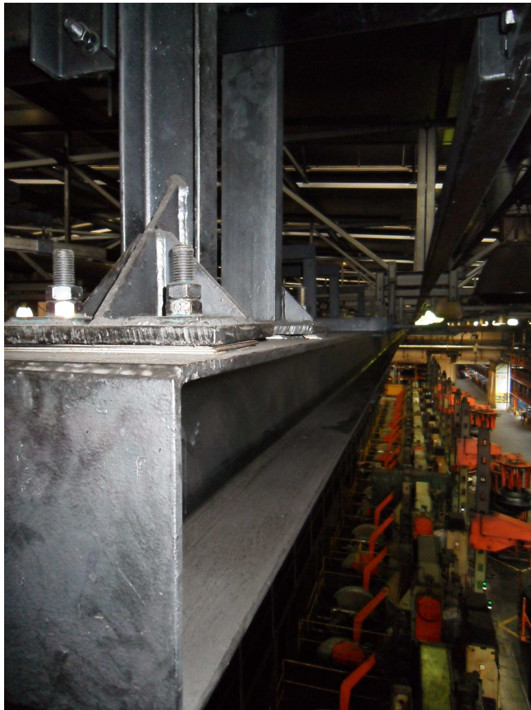
Obrázek 11.1 – Podvěsná dráha PD 0,5/6,8 – 56,59, lisovna AGRO, MITAS Otrokovice.
