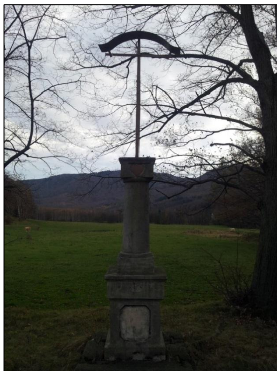
Obr. 6 Boží muka, objekt č. 739448-6-e
