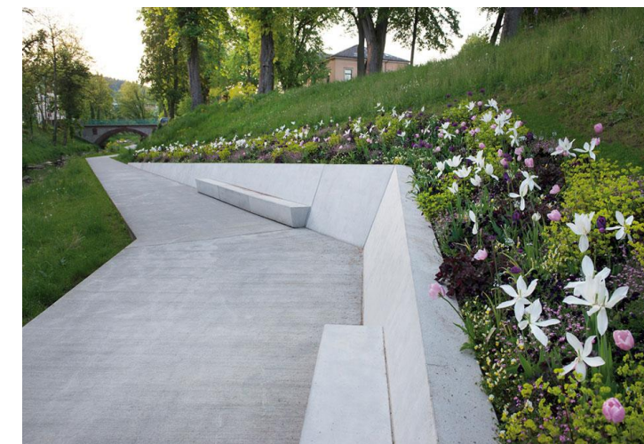
Obr. 35 Sedací prvky s opěrnou zdí
