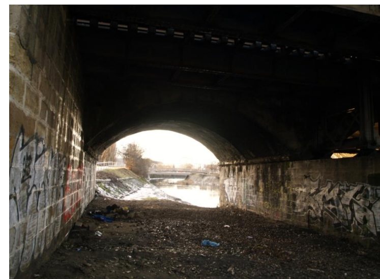
Obr. 89 Nevyužitý prostor pod viaduktem
