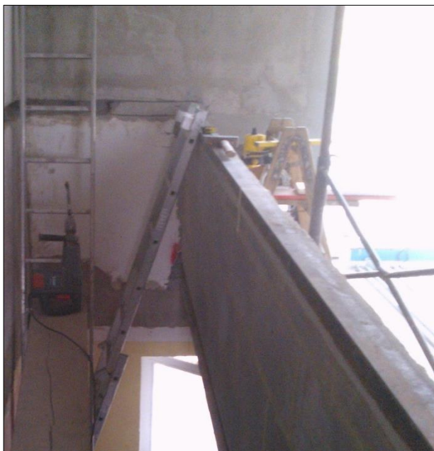
Obrázek č. 14 – Vyztužení příčky U profilem (foto majitel)
