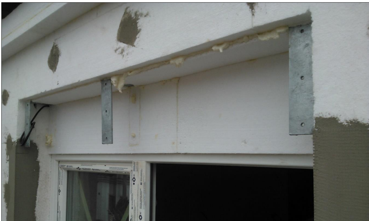
Obrázek č. 16 – Výroba prostoru pro venkovní žaluzie (foto majitel)
