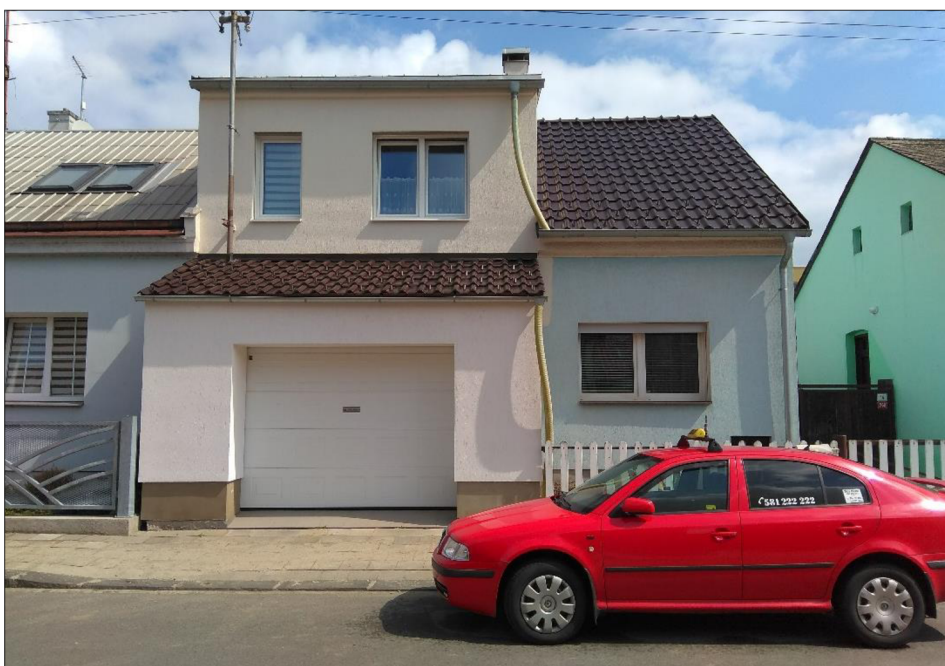
Obrázek č. 9 – Přístavba a nástavba v uliční části (foto vlastní)
