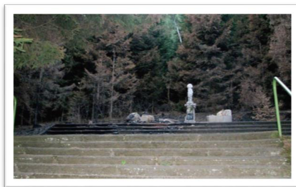
Obr. 13 - Kaple po požáru
