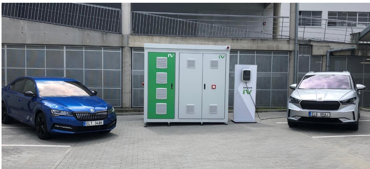
Obrázek 46 Kompaktní all-in-one bateriové úložiště DES [97]
