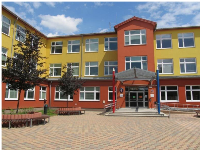
Obrázek 8 Budova zrekonstruované základní školy Šestajovice
