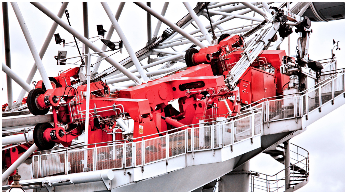
Obrázek 5.19 Pojezd rámu Londýnského oka a zároveň jeho pružné uchycení. Zdroj: flickr.com, úprava: Martin Hušek
