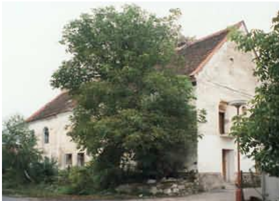
Obr. 2e. Pohled na neopravenou synagogu ve Čkyni
