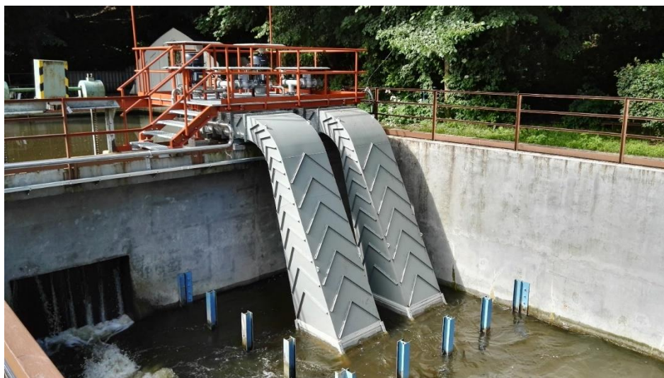
Obr. 7.1 Pohled na dvojici savek násoskových Vírových turbín MVE Želina
