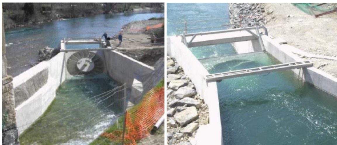
Obr. 1.7 Prototyp turbíny MJ2 ve Francii, Millau [10]
