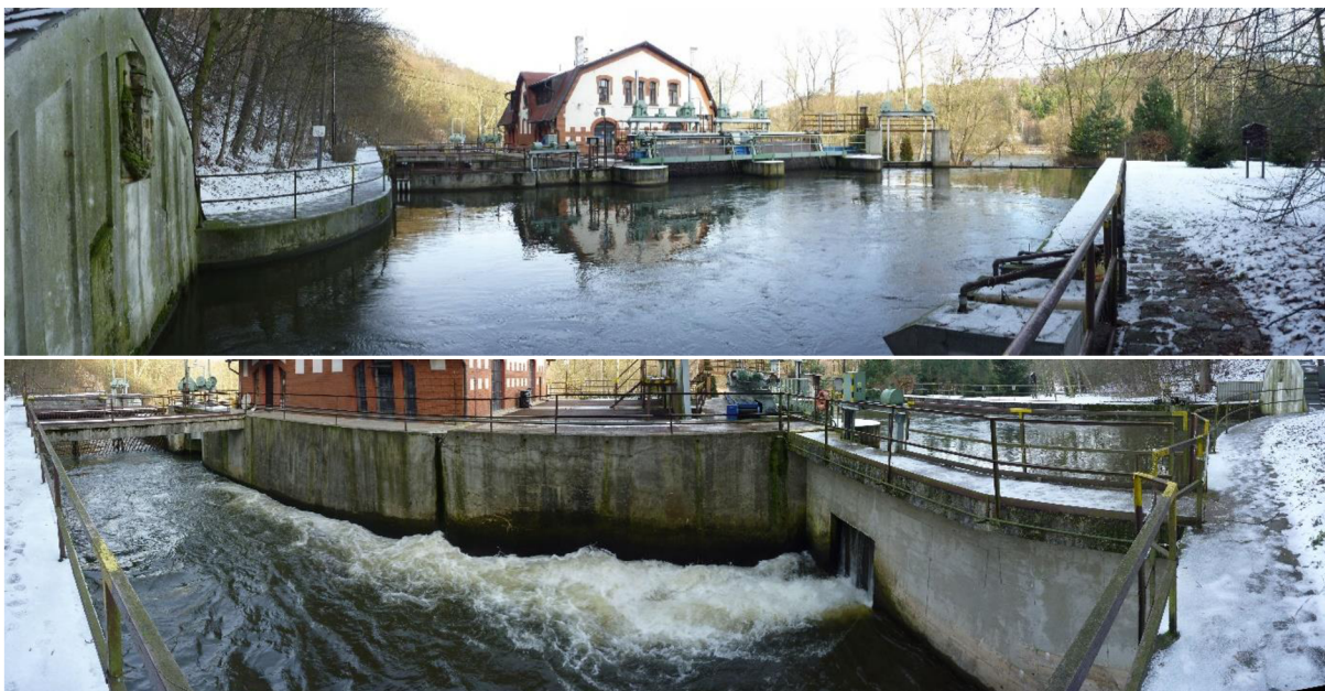
Obr. 3.12 MVE Želina a Lomazický kanál před vybudování MVE Želina 2
