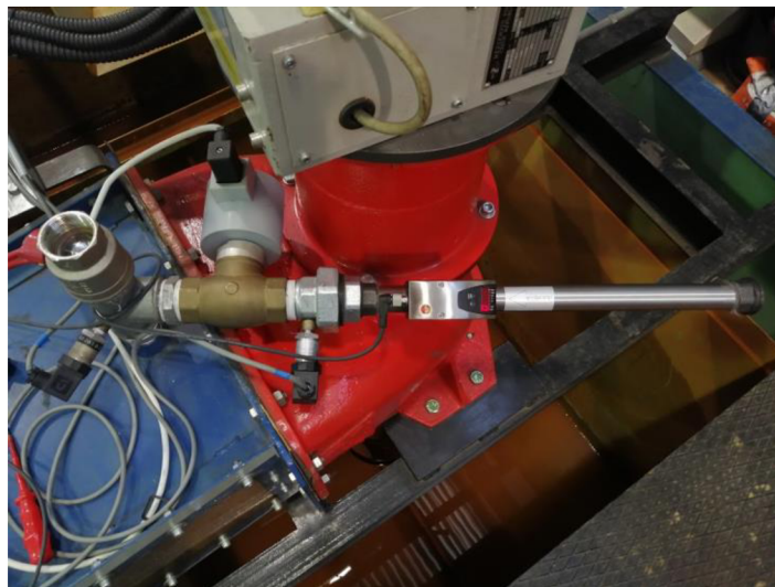
Obr. 5.19 Pohled na elektromagnetický ventil s clonou a průtokoměrem vzduchu TESTO
