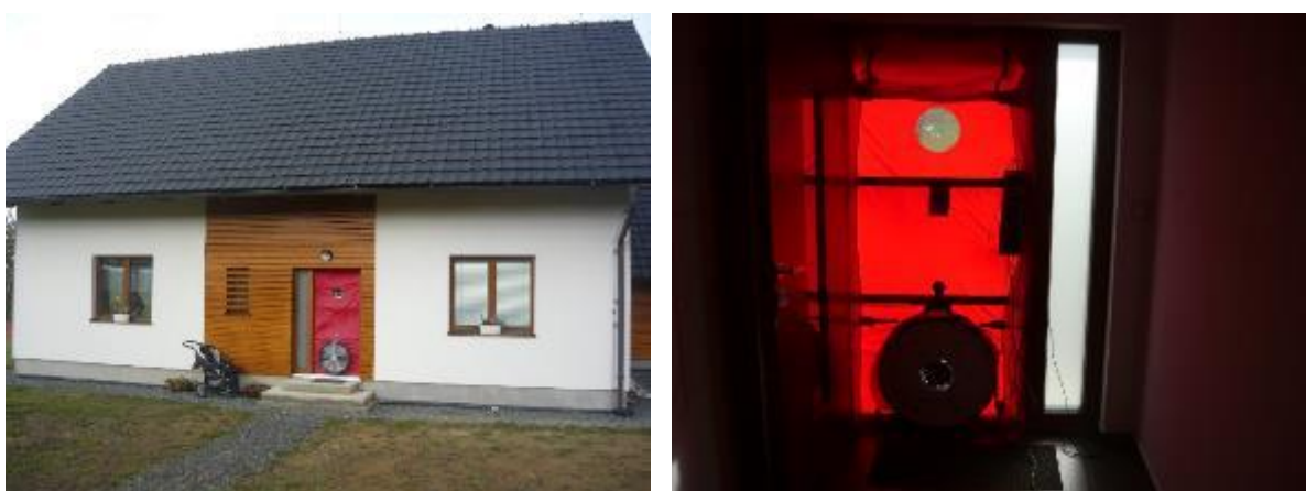
Obr. 38: Osazení měřicího zařízení (BLOWERDOOR) v měřené stavbě
