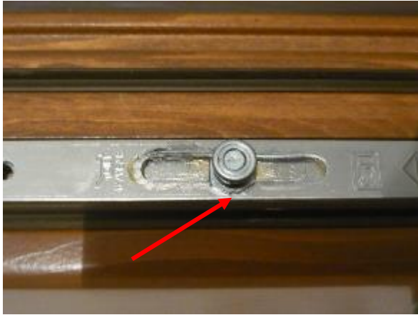
Obr. 39: Nastavení polohy kování na dotažení 0%
