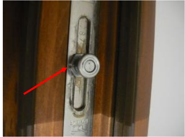
Obr. 39: Nastavení polohy kování na dotažení 0%
