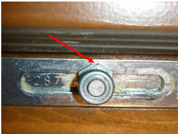
Obr. 41: Nastavení polohy kování na dotažení 100%
