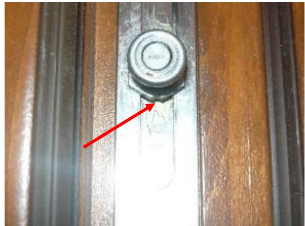
Obr. 40: Neutrální nastavení polohy kování na dotažení 50%
