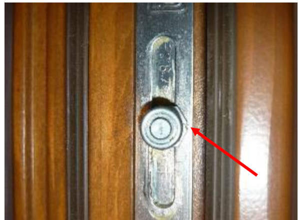
Obr. 41: Nastavení polohy kování na dotažení 100%
