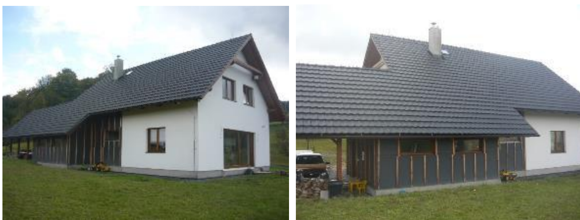
Obr. 37: Severovýchodní a severozápadní pohled na měřenou stavbu
