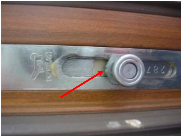
Obr. 40: Neutrální nastavení polohy kování na dotažení 50%
