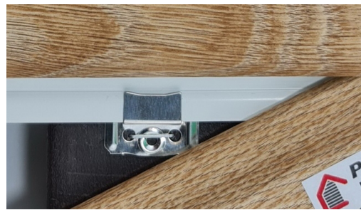
Obr. 3 Montáž plastových palubek [10].
