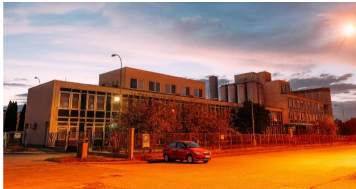
Obrázok 25: Hlavná budova so vstupom do areálu a parkoviskom pekárne (Zdroj: Webová stránka firmy)
