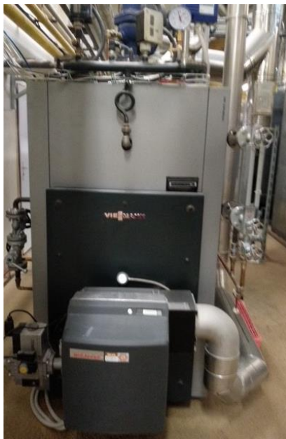
Obrázok 13: Centrálny vyvíjač pary (Zdroj: Vlastná tvorba)
