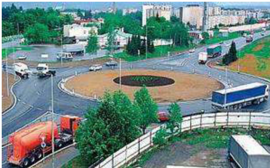
Obr. 22: a) Schéma intravilánové dvouproudové křižovatky, b) Příklad realizace křižovatky v České republice.
