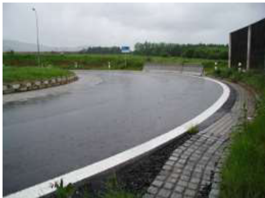
Obr. 9: Příliš široký okružní pás.
