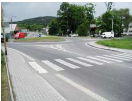
Obr. 12: Chybějící ochranný ostrůvek.
