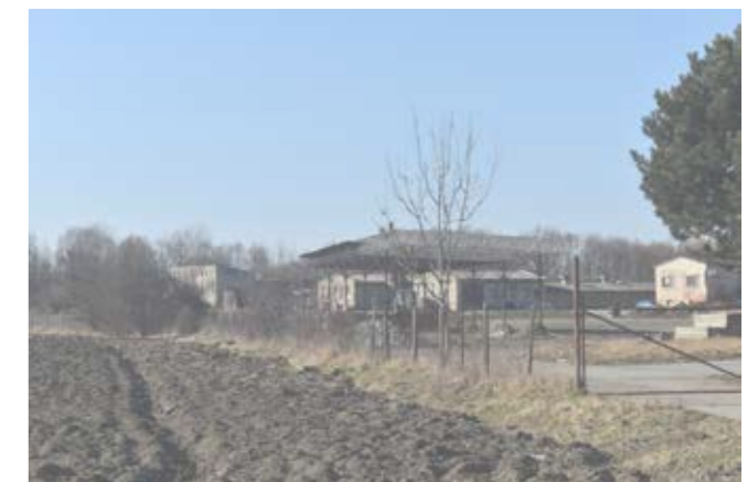
Část budov, které jsou využívány jako sklady
