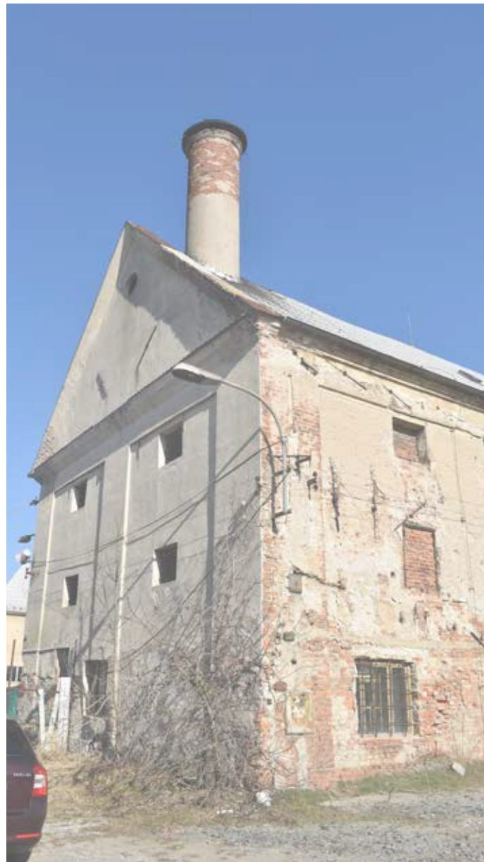
Hlavní budova pivovaru a sladovny
