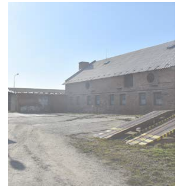
„Nová“ budova kravína
