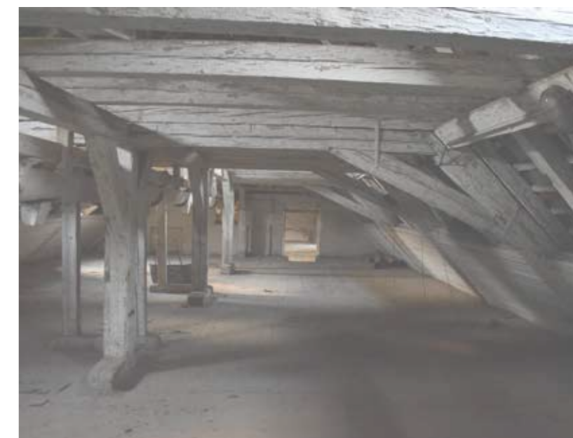
Krov navazující na místnosti v 3.NP
