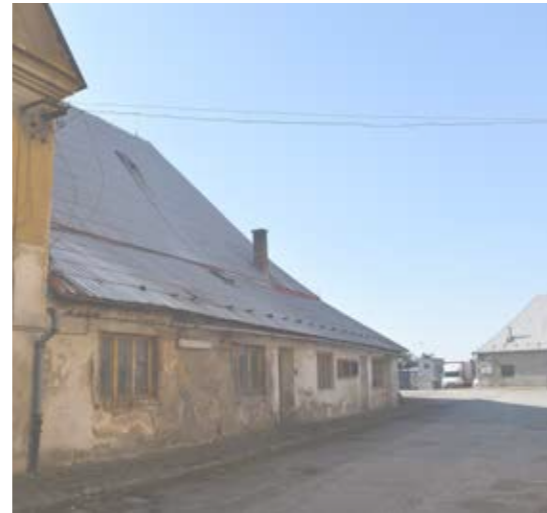
Budova vrátnice u vstupu do areálu
