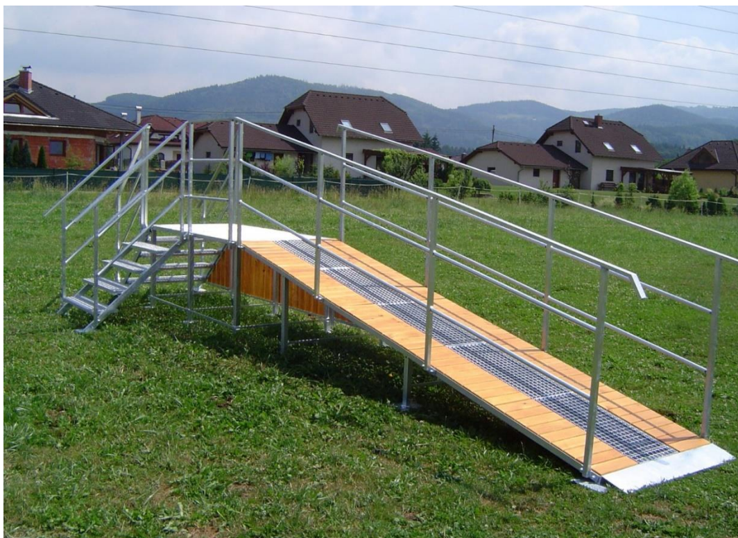
(Obrázek č. 1, nástupní rampa s nájezdovou částí i se schody)
