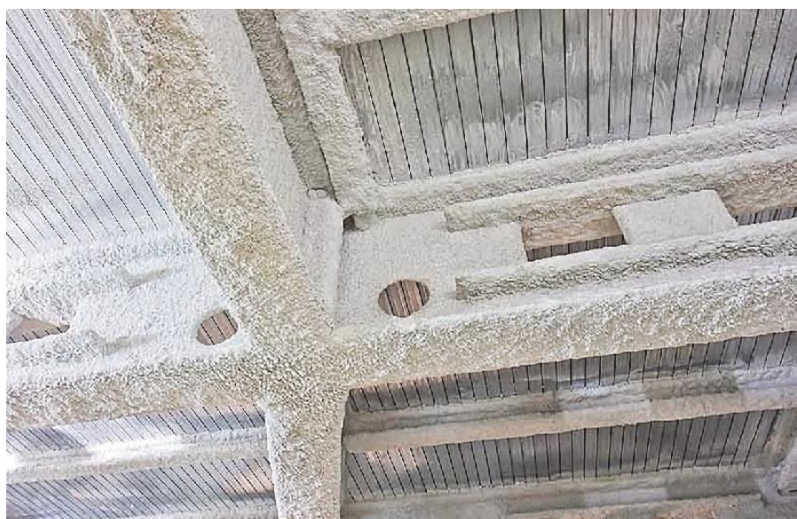
Obrázek 19 Hrubá struktura protipožárního nástřiku [27]
