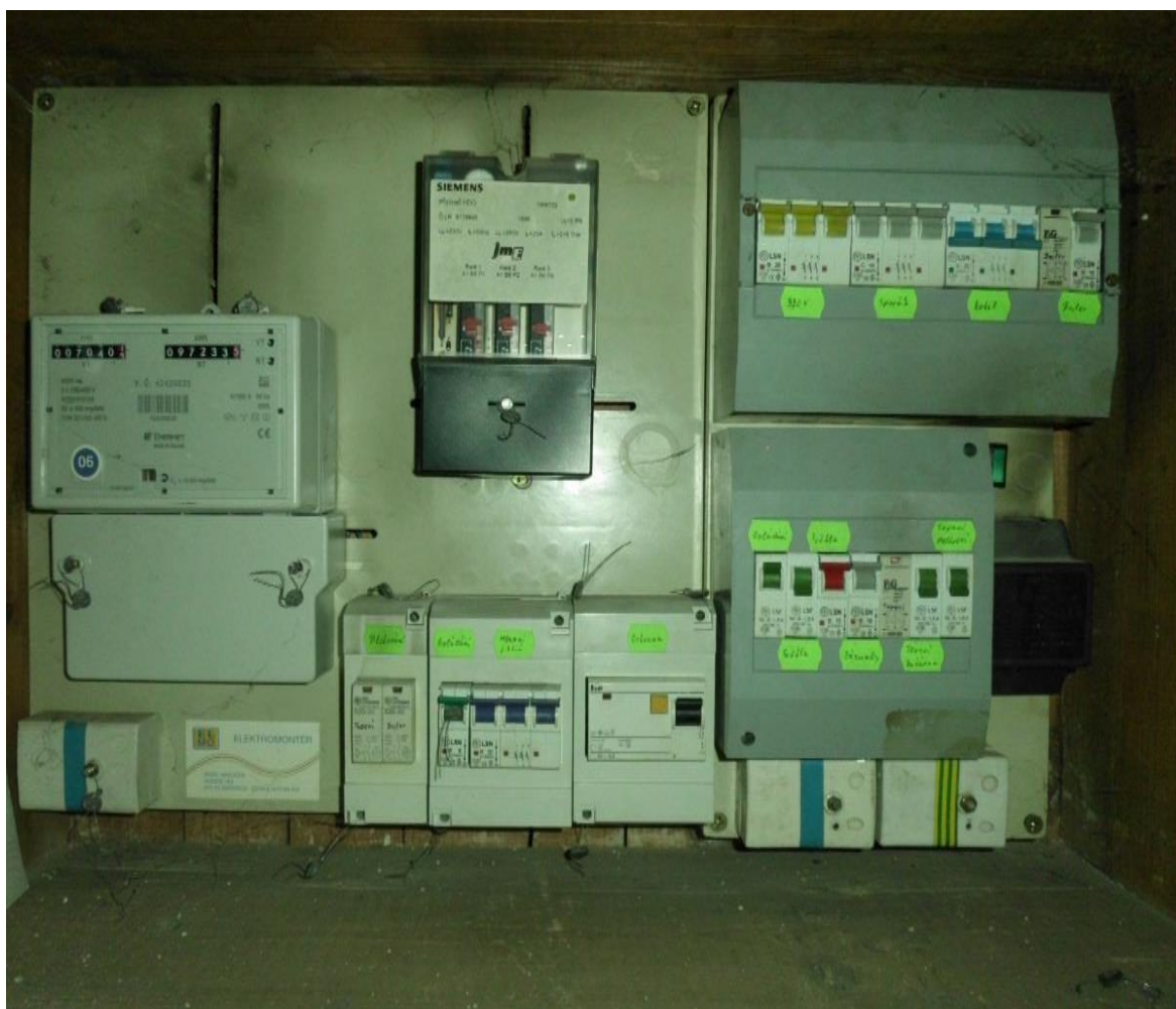
Obrázek 22 Hlavní rozváděč
