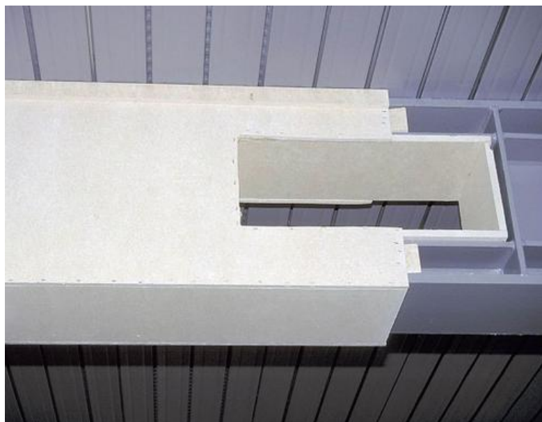
Obrázek 18 Deskový obklad chránící ocelový nosník [26]
