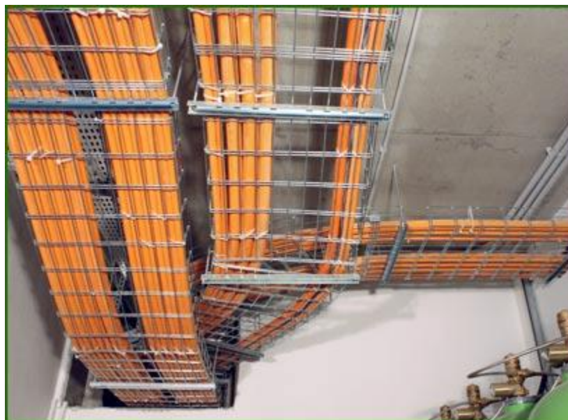
Obrázek 7 Drátový kabelový žlab typický pro průmysl [9]
