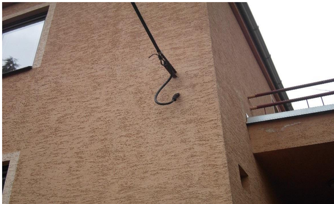
Obrázek 21 Připojení RD k síti nn
