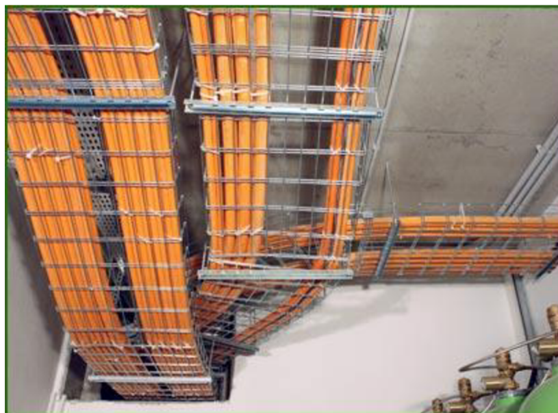
Obrázek 7 Drátový kabelový žlab typický pro průmysl [9]
