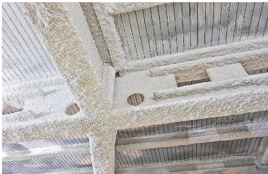
Obrázek 19 Hrubá struktura protipožárního nástřiku [27]
