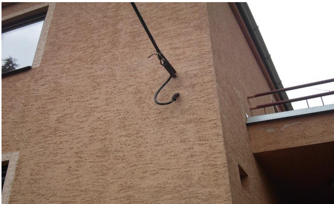
Obrázek 21 Připojení RD k síti nn
