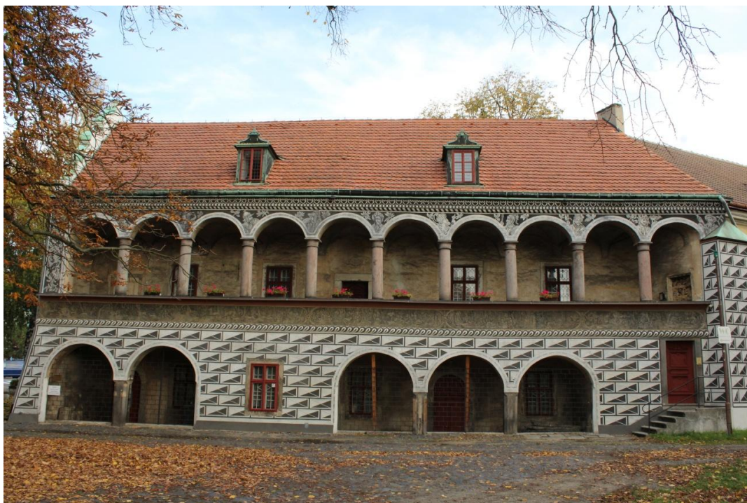
5. obr. Česká Lípa, Červený dům, pohled na jižní průčelí
