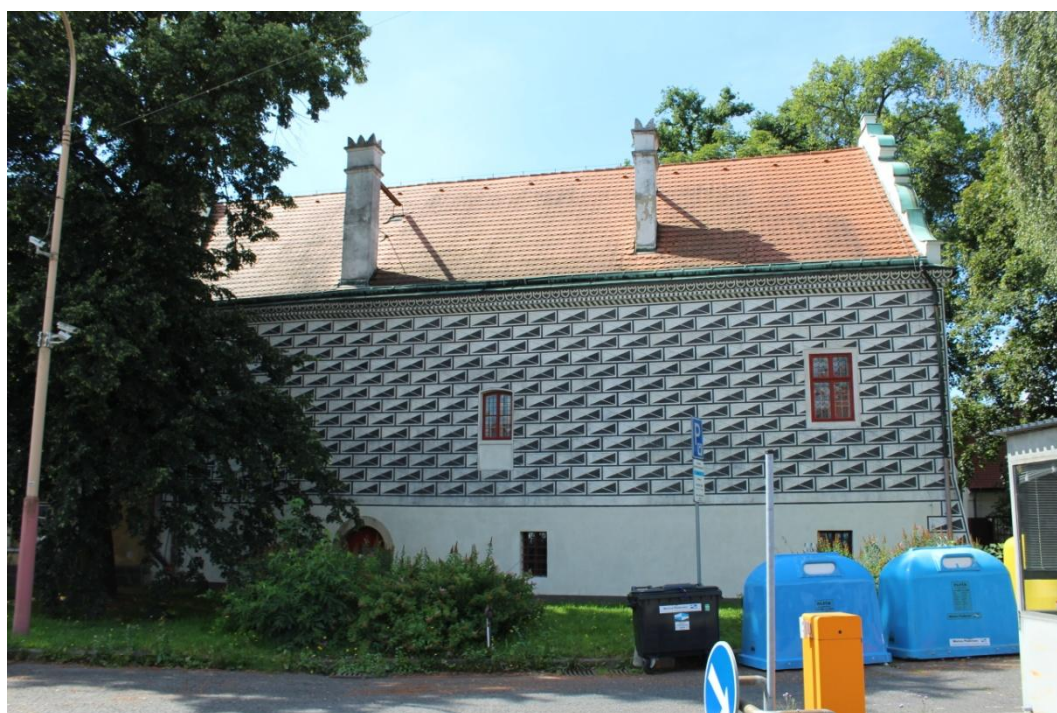
8. Obr. Česká Lípa, Červený dům č.p. 57 pohled na severní fasádu, foto
