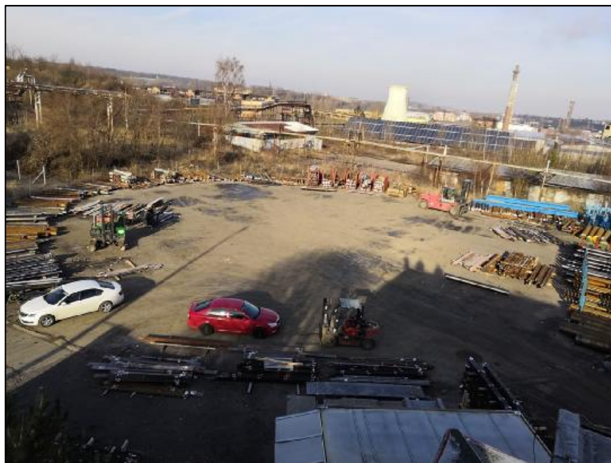
Obrázek 7: Současný stav (leden 2019), betonový základ plynojemu
