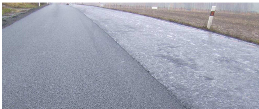
Obr. 15: Ukázka odvodnění gumoasfaltového koberce drenážního (PA 8 CRmB) [4]
