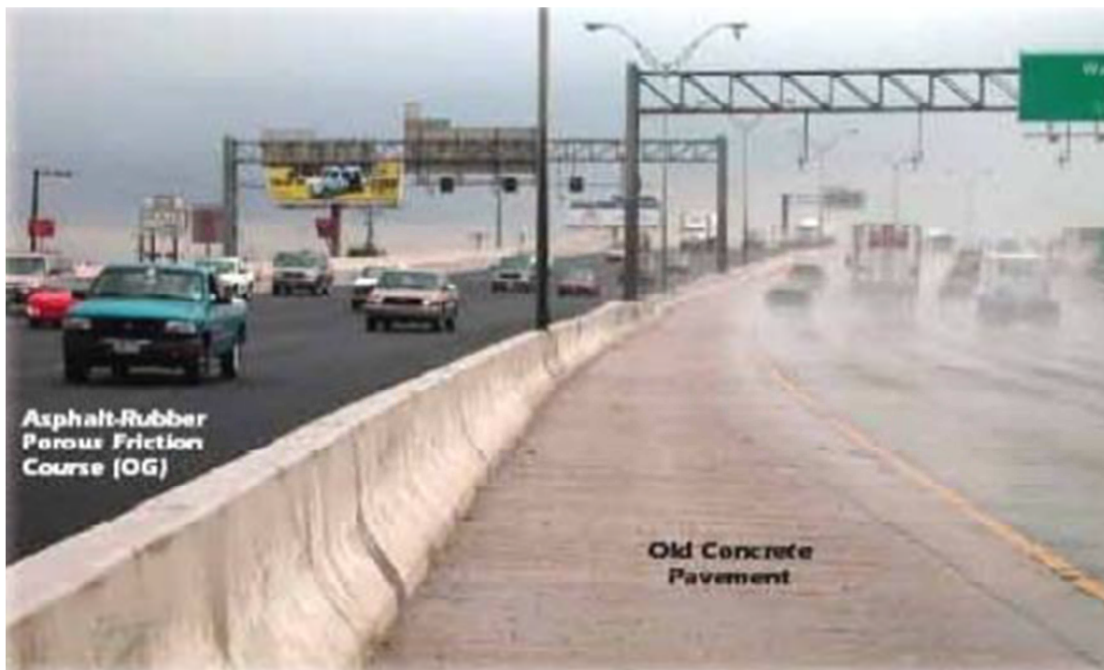
Obr. 13: Porovnání odvodnění porézního koberce a cementobetonového [4]
