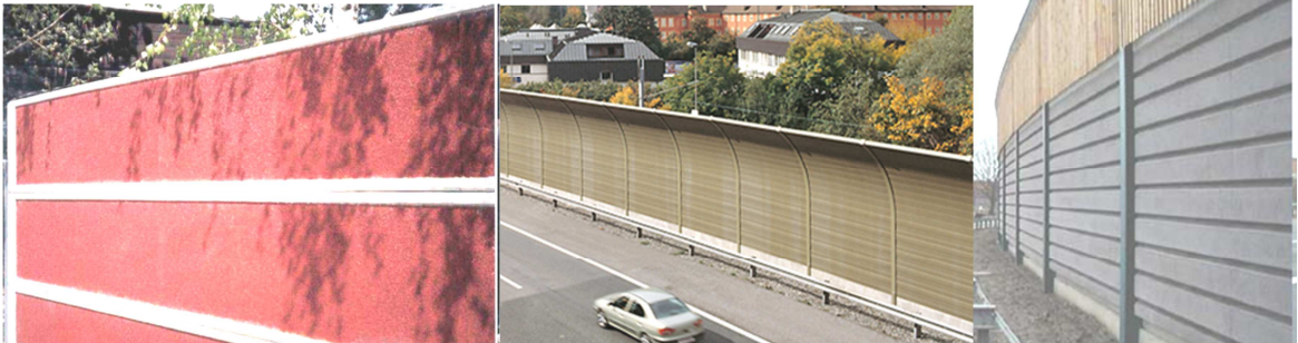
Obr. 10: Protihlukové stěny z pryže, hliníku a dřeva [9]
