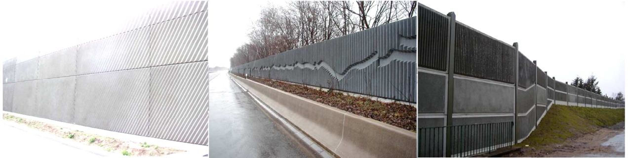
Obr. 9: Ukázka různých protihlukových stěn typu LIADUR [9]
