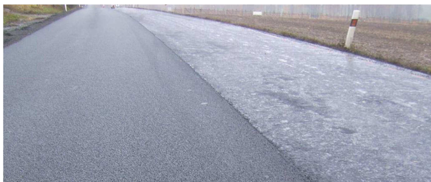
Obr. 15: Ukázka odvodnění gumoasfaltového koberce drenážního (PA 8 CRmB) [4]
