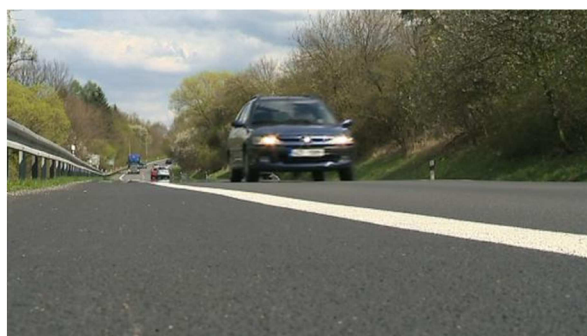
Obr. 23: Asfaltový koberec u Zádveřic [12]
