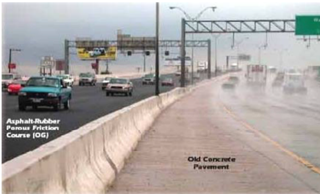
Obr. 13: Porovnání odvodnění porézního koberce a cementobetonového [4]
