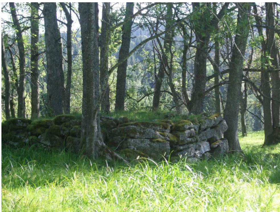
Obrázek 11 – Pozůstatky kamenných základů bývalého stavení v Dolních Světlých Horách
