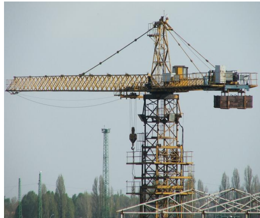
Obr.34 Věžový jeřáb MB 2043
