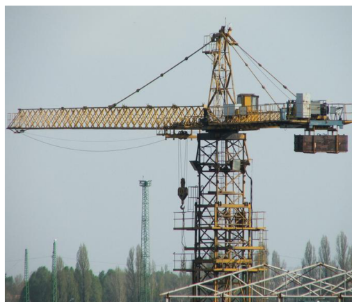
Obr.34 Věžový jeřáb MB 2043
