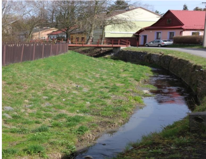
Obrázek 12: Koryto řeky Svitavy na ulici U Tří dvorů (foto: P. Dřímál, březen 2016)
