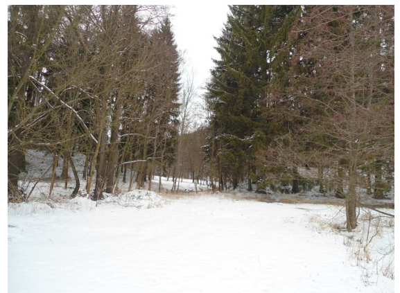
Obr. č. 18 Prokopaná hráz zaniklého rybníka Krežma v Meziboří, kudy vytéká vodní tok (Šustrová, 2013)
