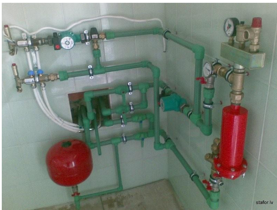
Obr. 26 - Ukázka zapojení ionizačního kotle Stafor [38]
