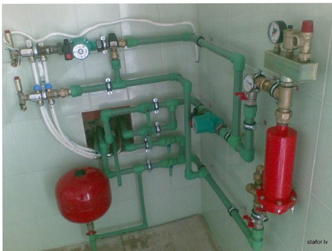
Obr. 26 - Ukázka zapojení ionizačního kotle Stafor [38]
