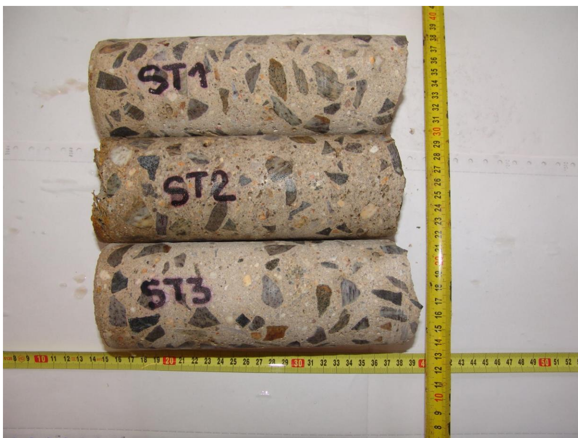
Obrázek 14: Jádrové vývrty betonu sloupů, průměr 75 mm
