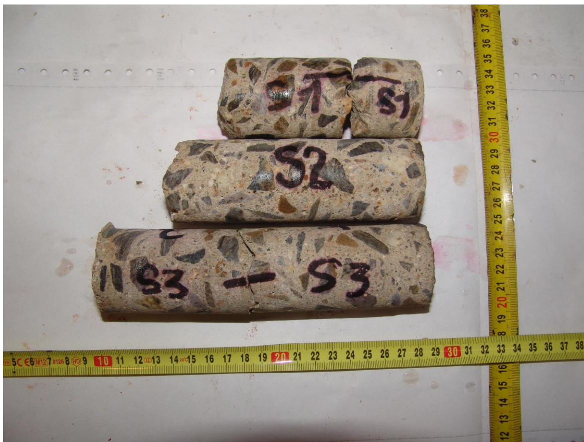
Obrázek 12: Jádrové vývrty betonu stropní desky, průměr 45mm
