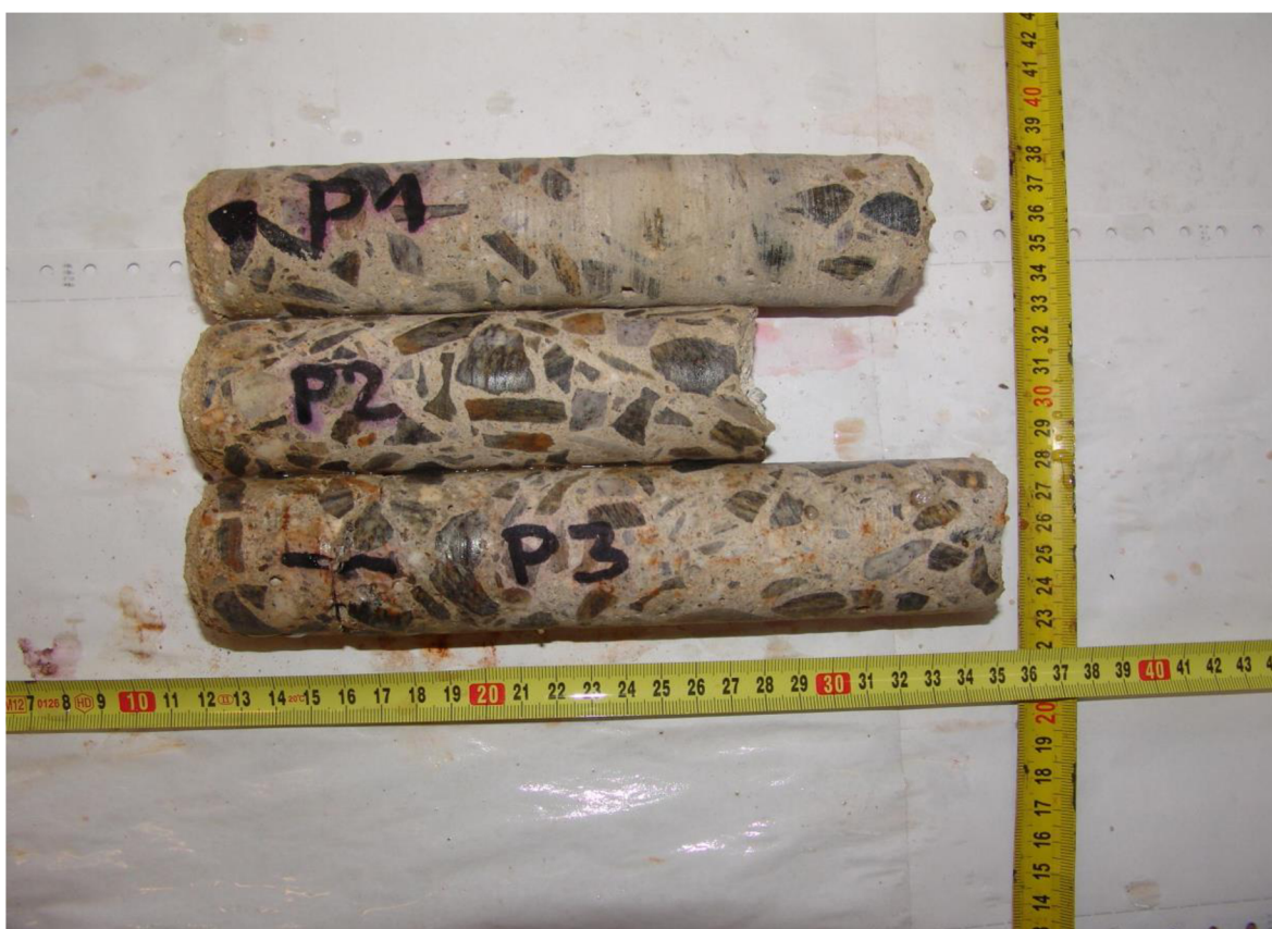
Obrázek 13: Jádrové vývrty betonu trámu, průměr 45 mm
