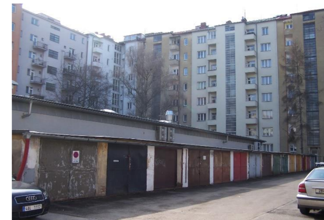
Obr. 35: Zastavění části vnitrobloku supermarketem a garážemi, Bayerova, Brno
