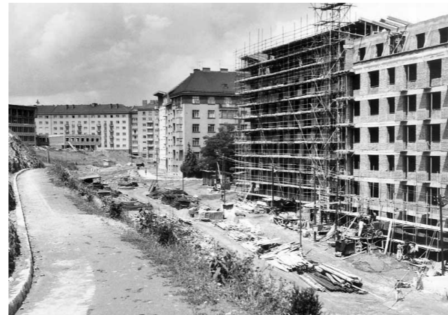
Obr. 80: 1960 – Stavba ulice Úvoz a obytné zástavby (2. vnitroblok)
