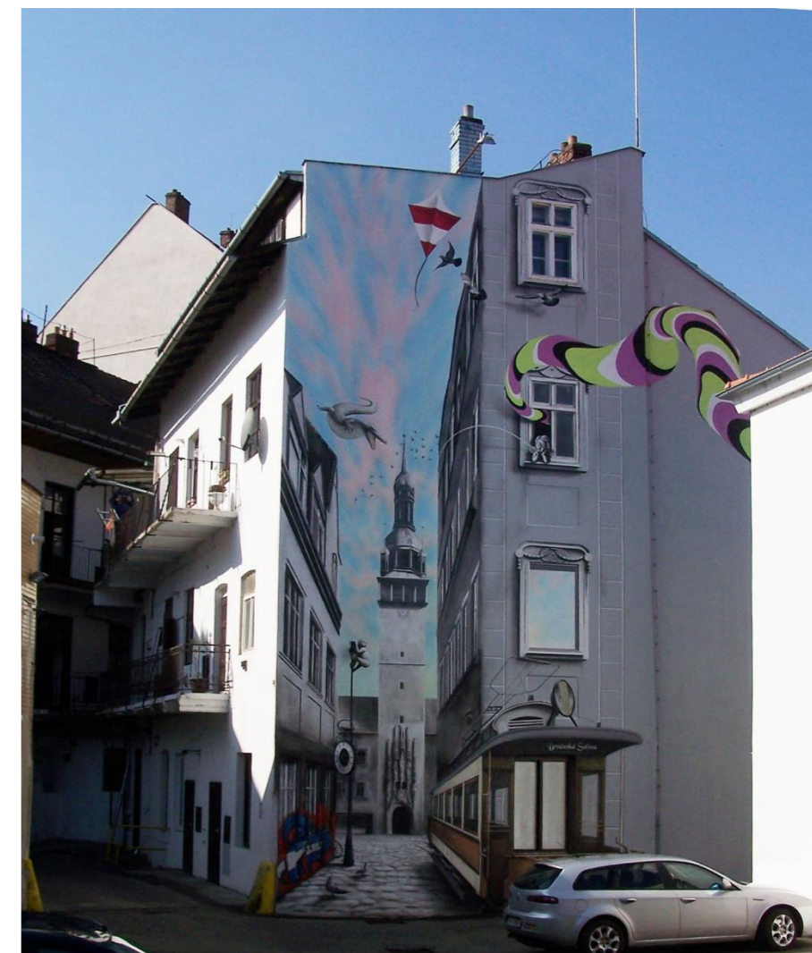
Obr. 22: Graffiti ozvláštňující stěnu nenápadného dvora v zastavěném vnitrobloku. Dvůr Václavská, Brno
