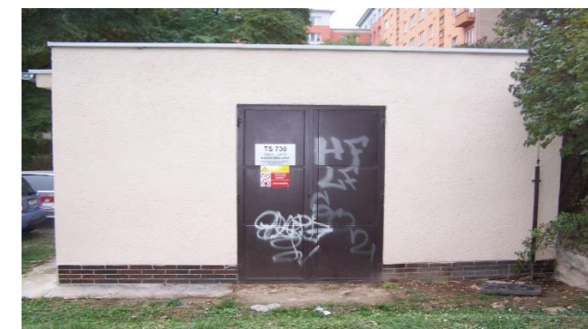
Obr. 36: Trafostanice. Jejich umístění je často náhodné. Vnitroblok Čápkova, Brno
