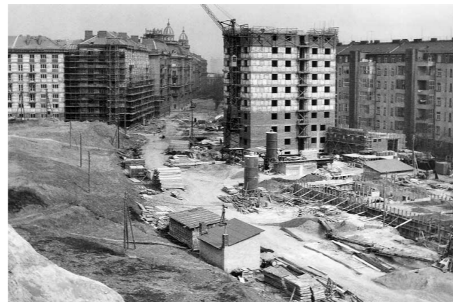
Obr. 81: 1959 – Stavba ulice Úvoz a obytné zástavby (1. vnitroblok)
