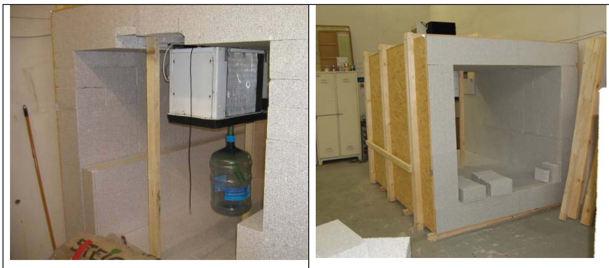
Obr. 12 Izolace měřicího boxu s výparníkem
