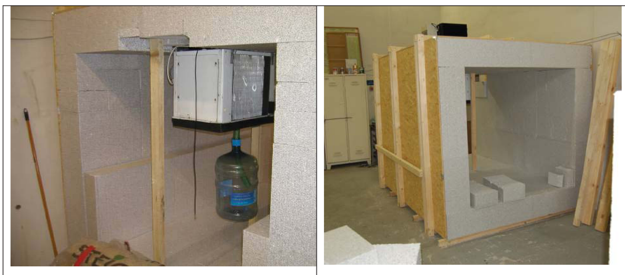
Obr. 12 Izolace měřicího boxu s výparníkem
