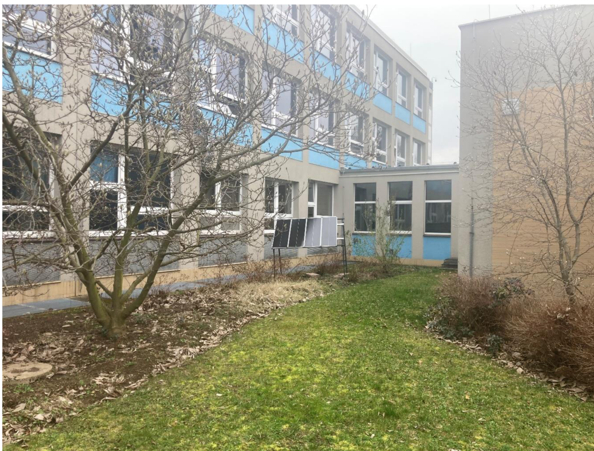
Obrázek 19 - Umístění fotovoltaických panelů mezi budovami
