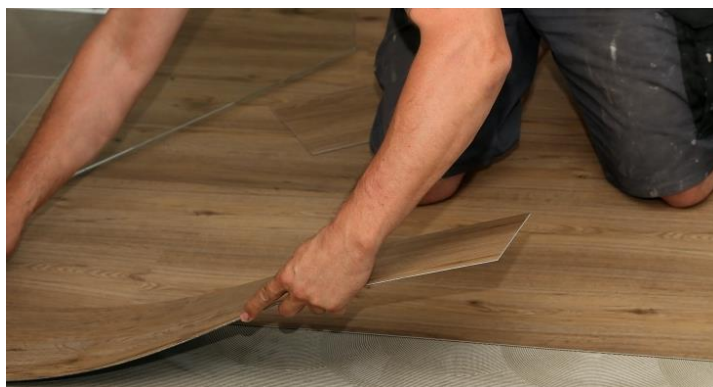
Obr. 2: Pokládka vinylové podlahy
