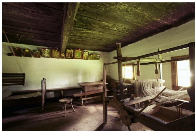
Obr. 3: V přízemí domu hliněná podlaha, v patře na trámech dřevěná prkna.
