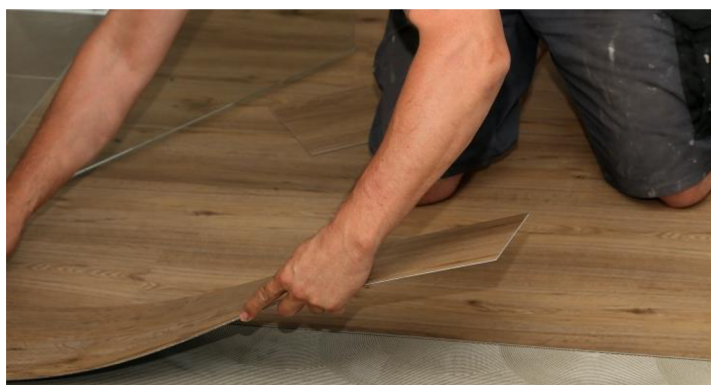
Obr. 2: Pokládka vinylové podlahy
