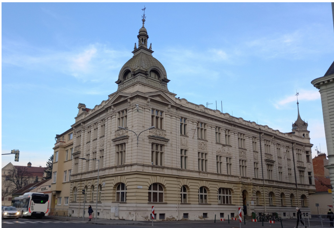
Obr. č. 1 Hlavní budova ZUŠ Vladimíra Ambrose, Kravařova 14 454
