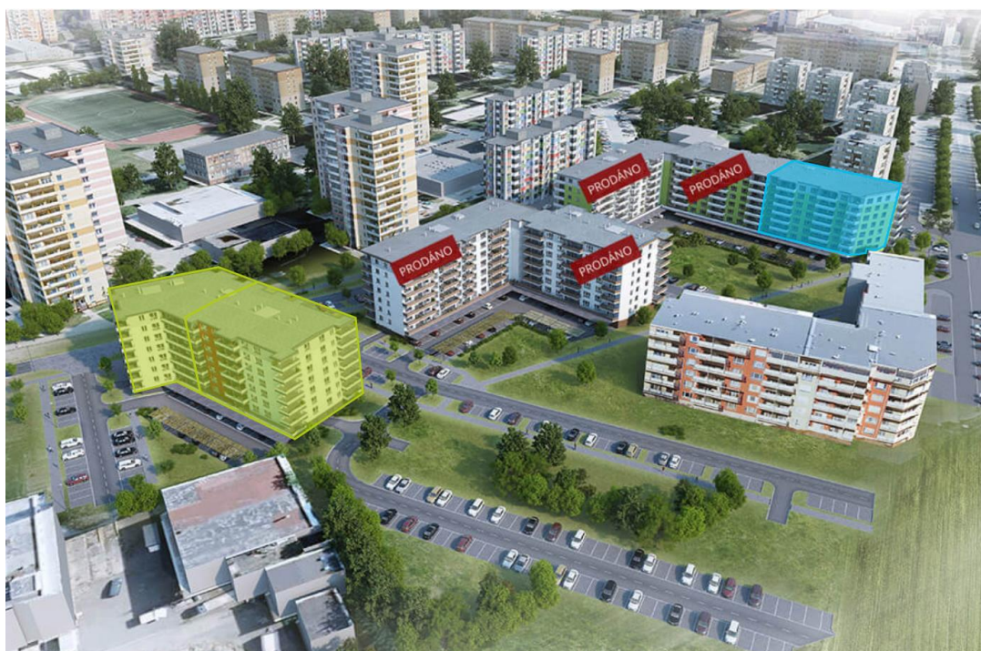
Obr. 6 - Komplex na ulici Jánského vybudovaný Stafosem [13]
