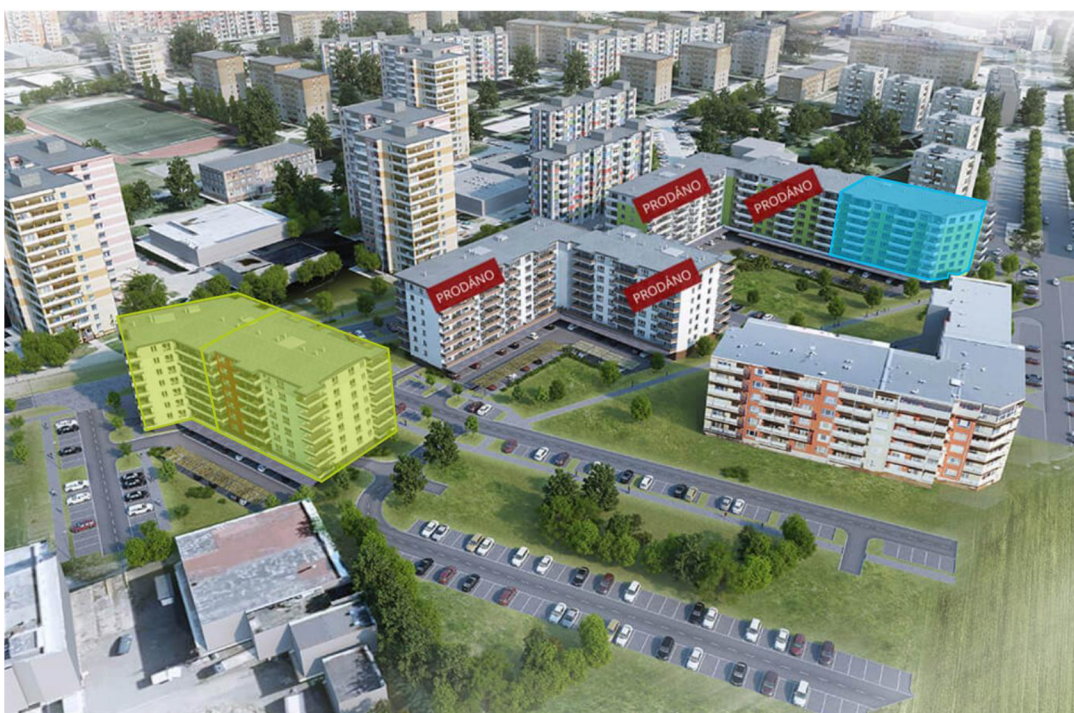
Obr. 6 - Komplex na ulici Jánského vybudovaný Stafosem [13]
