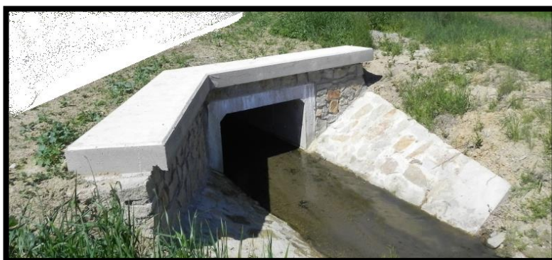
Obr. 49: propustek nad střediskem ZD
