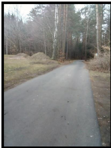
Obr. 34: zrekonstruovaná cesta VC44A
