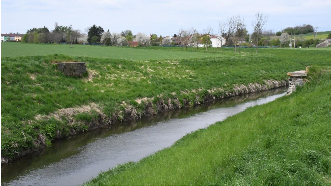
Obr.19 Pozůstatky mostu přes řeku Haná u Dřevnovic (Křepelka P., květen 2021)
