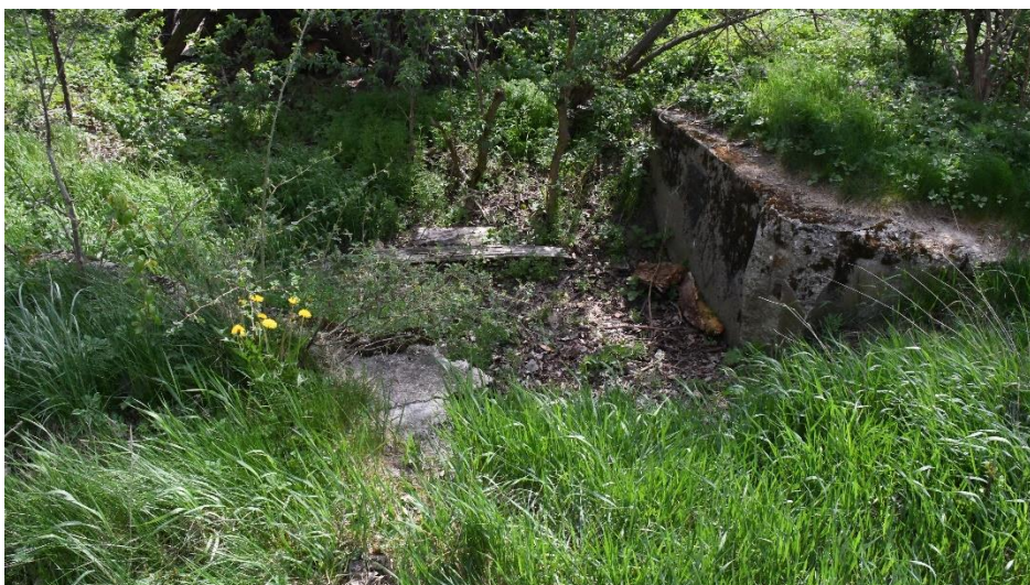
Obr.21 Pozůstatky stavidla při začátku mlýnského náhonu z Hané u Nezamyslic (Křepelka P., květen 2021)
