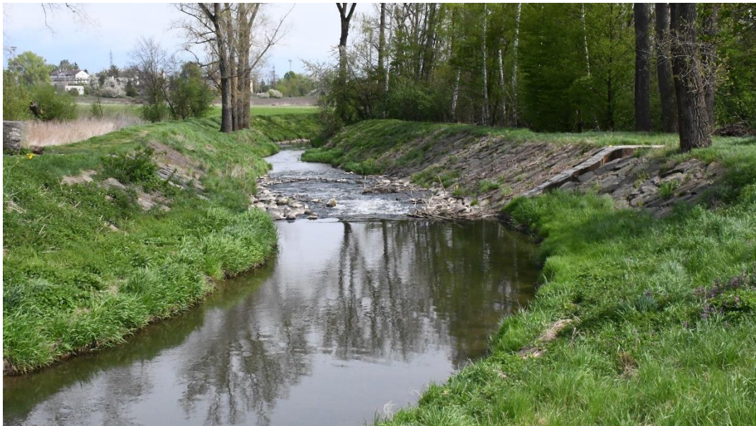
Obr.20 Upravený splav na řece Hané u Nezamyslic (Křepelka P., květen 2021)
