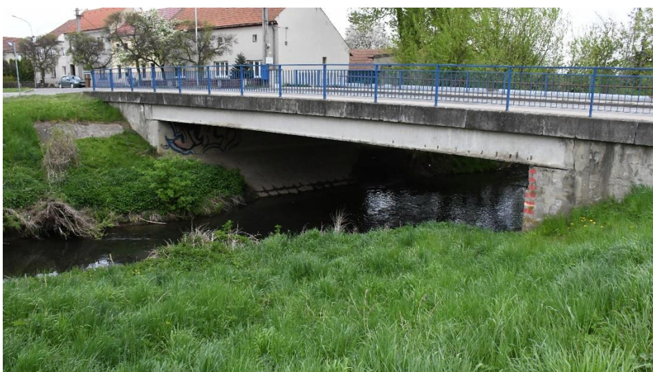
Obr.22 Most přes řeku Haná v Nezamyslicích (Křepelka P., květen 2021)
