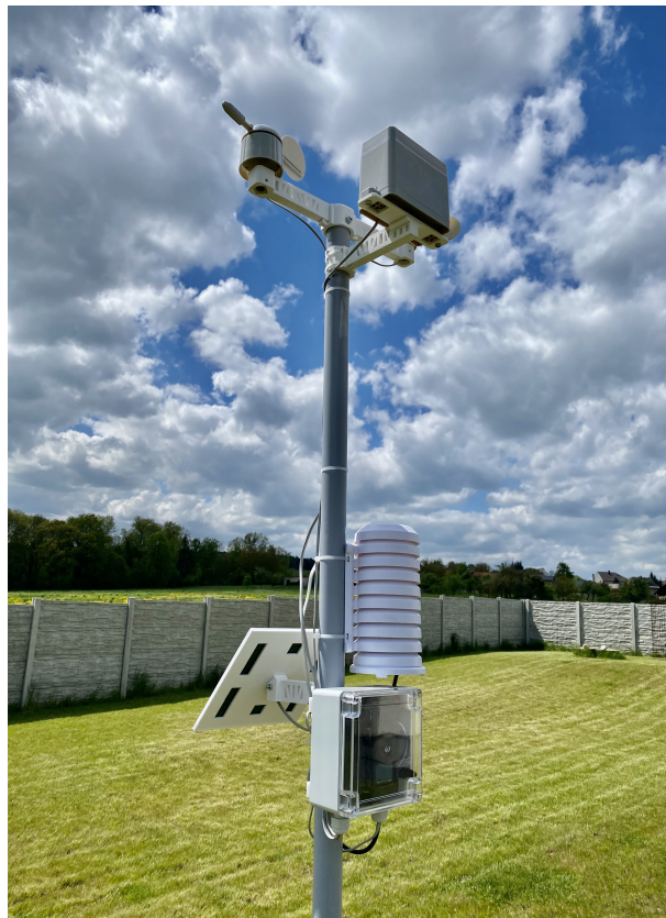
Obr. 5.2: Výsledná konstrukce meteostanice
