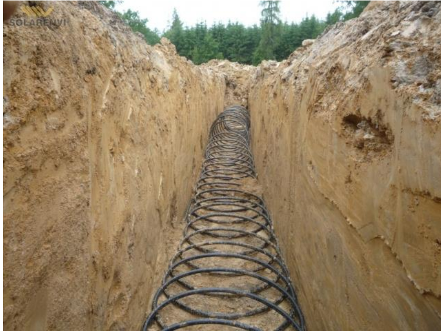
Obr. 6: Výměník typu Slinky [5]
