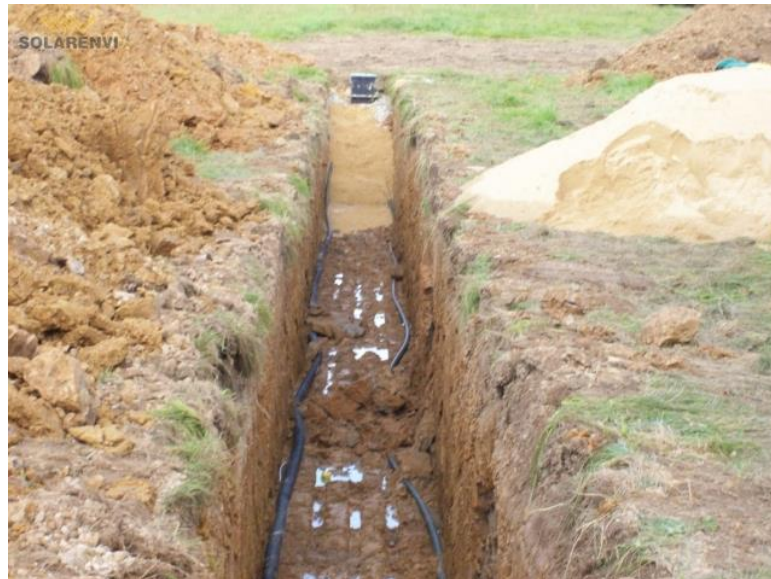
Obr. 4: Lineární tepelný výměník [5]
