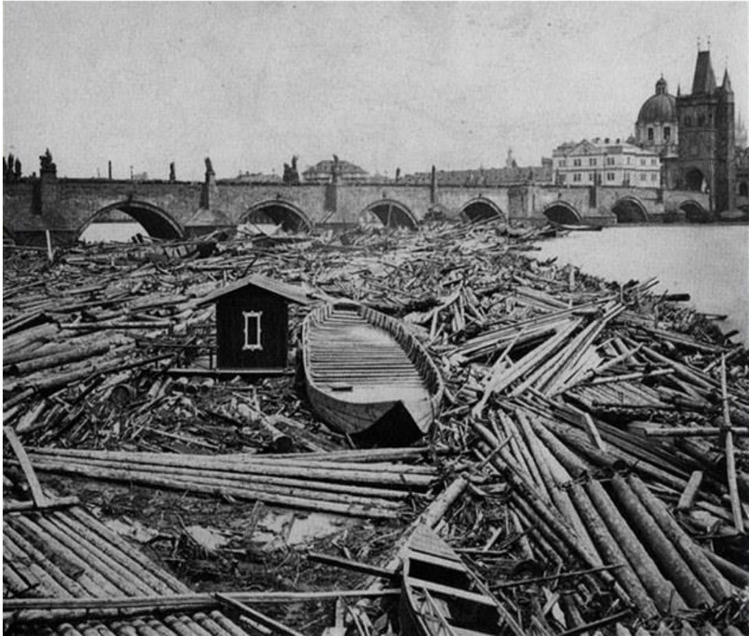
Obr. 6 - Akumulace naplaveného dřeva při povodni v roce 1872 u Karlova mostu ( POVODNĚ V PRAZE, 2013)
