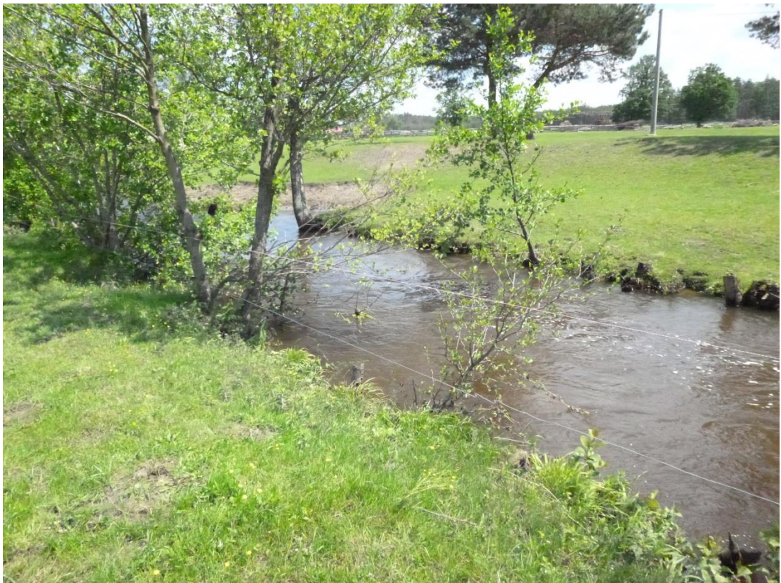
Příloha č.6 – Snížená ochranná hráz, v pozadí další břehová eroze (foto: V. Podlaha)
