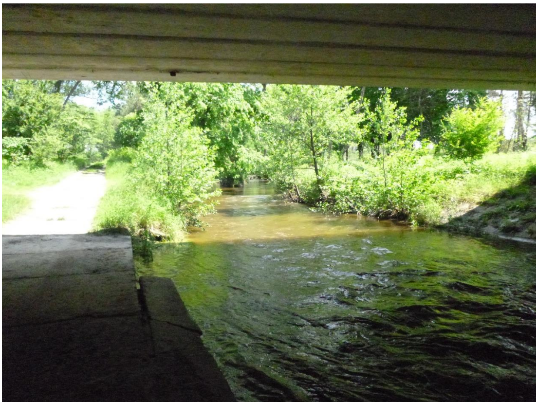
Příloha č.4 – Nátok do upravené části pod mostem dálnice D2 (foto: V. Podlaha)
