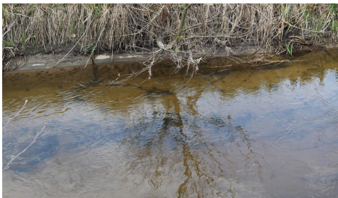
Obr. 13 - Detail betonového opevnění koryta (foto: Doc. Andrej Škrinár)
