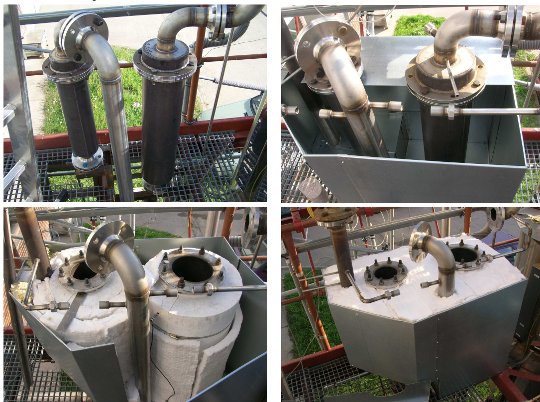
Obr. 72 Instalace filtrů
